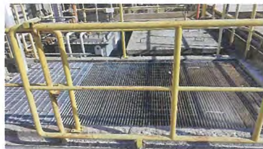
ภาพที่ 2.2-6 รางระบายน้ำเพื่อรองรับน้ำเสียและน้ำฝนจากกิจกรรมการก่อสร้าง
