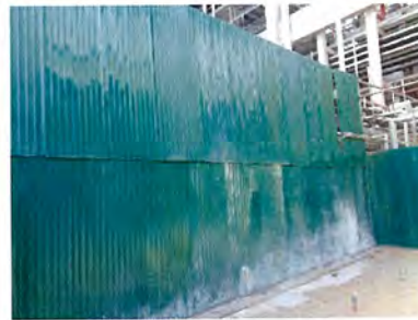
ภาพที่ 2.2-4 รั้วหรือแผงกั้นฝุ่นโดยรอบพื้นที่ก่อสร้าง
