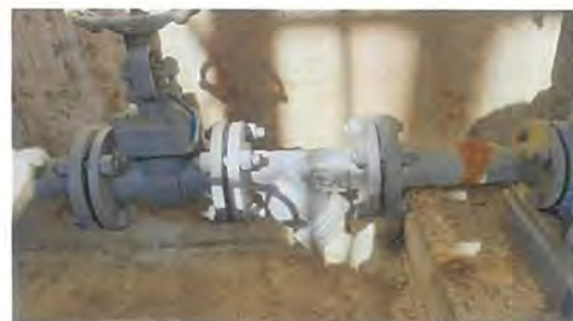
ภาพที่ 2.2-8 ตะแกรงดักตะกอนดิน ทราย และเศษขยะก่อนระบายน้ำทิ้งเข้าสู่บ่อพักน้ำ
