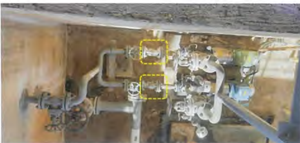
ภาพที่ 2.2-8 ตะแกรงดักตะกอนดิน ทราย และเศษขยะก่อนระบายน้ำทิ้งเข้าสู่บ่อพักน้ำ
