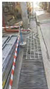
ภาพที่ 2.2-6 รางระบายน้ำเพื่อรองรับน้ำเสียและน้ำฝนจากกิจกรรมการก่อสร้าง
